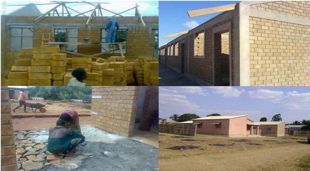
Processo de construção com recurso ao material local- Tijolo solo-cimento
