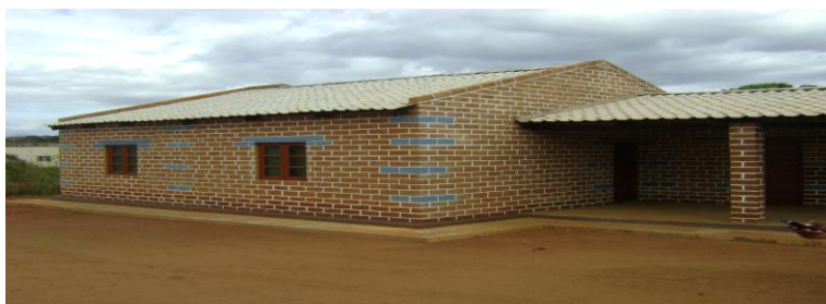
Processo de construção com recurso ao material local- Tijolo solo-cimento
