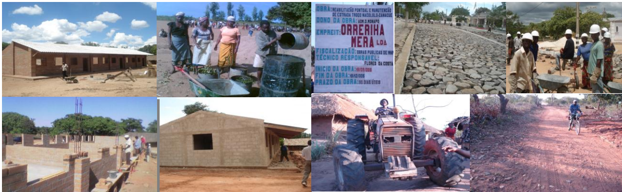
MERAs de Construção Civil Meconta, Erati e Ribaué
