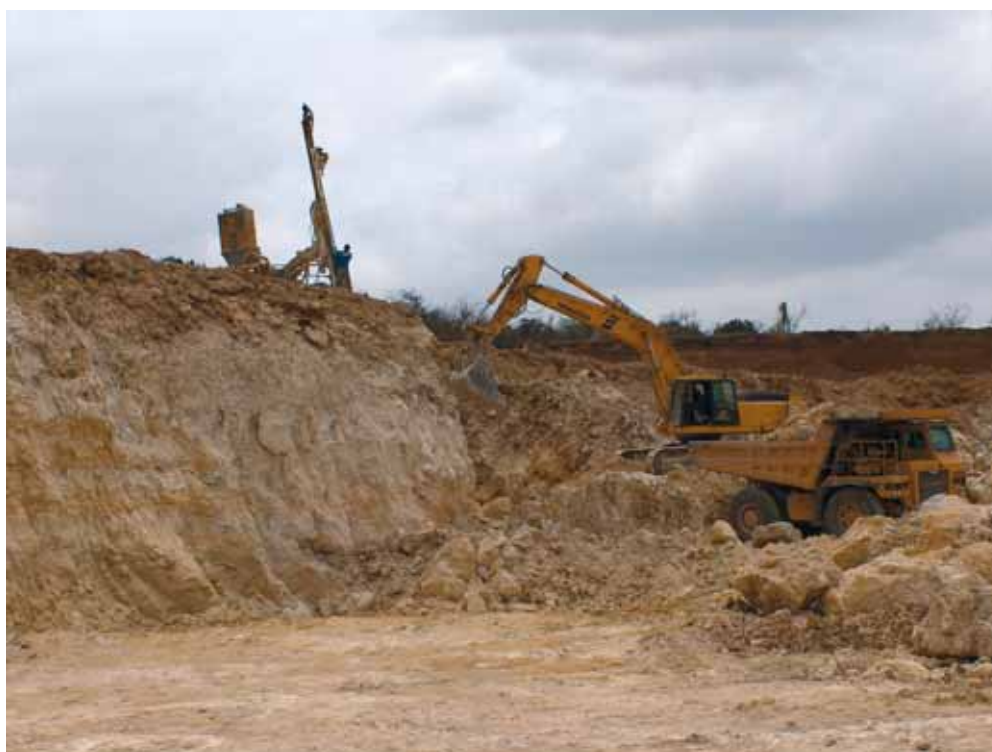
Fig. 3. Salamanga limestone quarry, Bela Vista.
