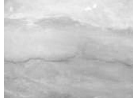
Fig. 6 Racha no edifício do P/A de Urrene
