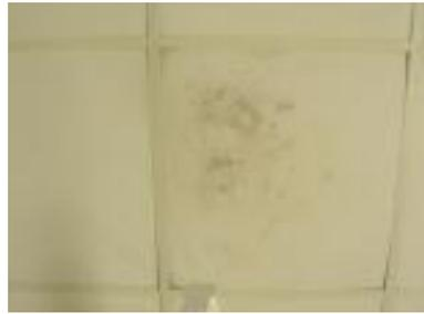
Fig. 11 Infiltração de água da chuva
