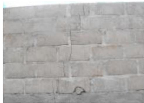
Fig. 9. Racha na parede duma das salas
