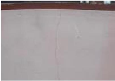
Fig. 10 Racha na parede
