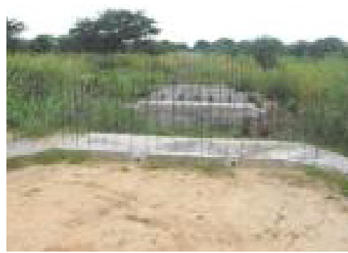
Fig. 8 Ponte sobre o rio Mussemete
