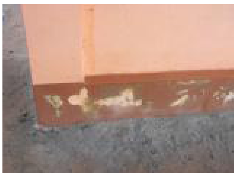
Fig.10 Tinta descascada
