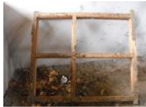
Fig. 15 Madeira danificada por muchém
