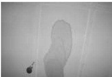
Fig. 9 Infiltração na residência do Procurador
