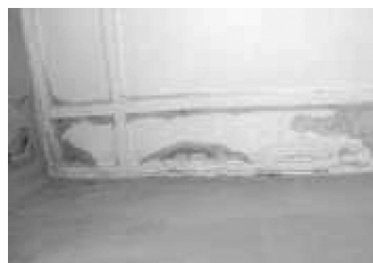
Fig. 2: Residência do Chefe da Meteorologia
