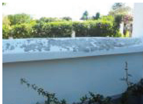
Fig. 2 Muro da Residência Oficial da Administradora
