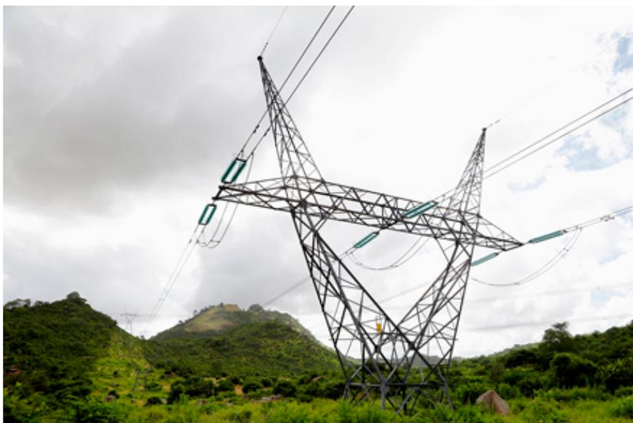
Pretende-se tornar as torres que suportam as linhas mais robustas e seguras, sendo que, para o efeito, foram projectadas construções de fundações amplas e mais profundas, com capacidade para suportar a força das águas em períodos de pico das chuvas.
